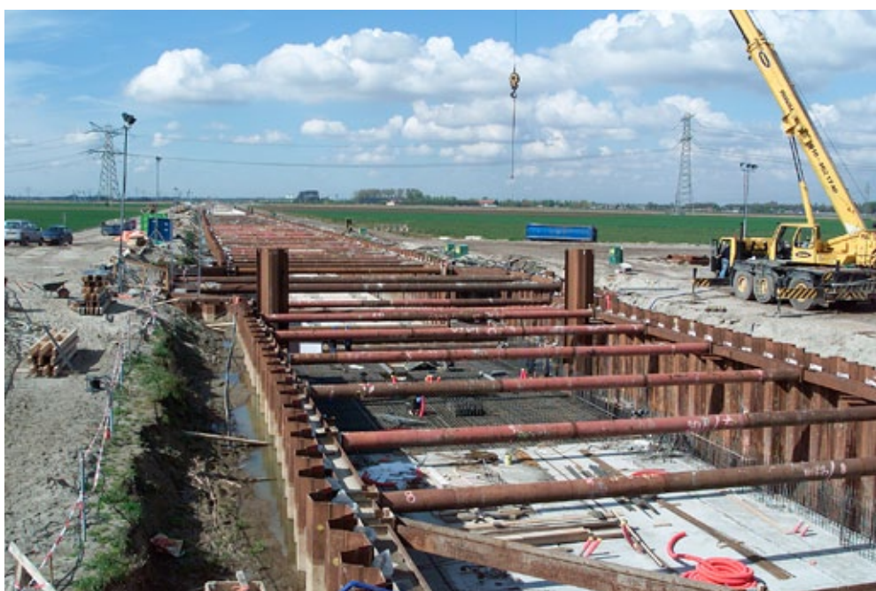
Aanleg tunnel Hogesnelheidslijn
