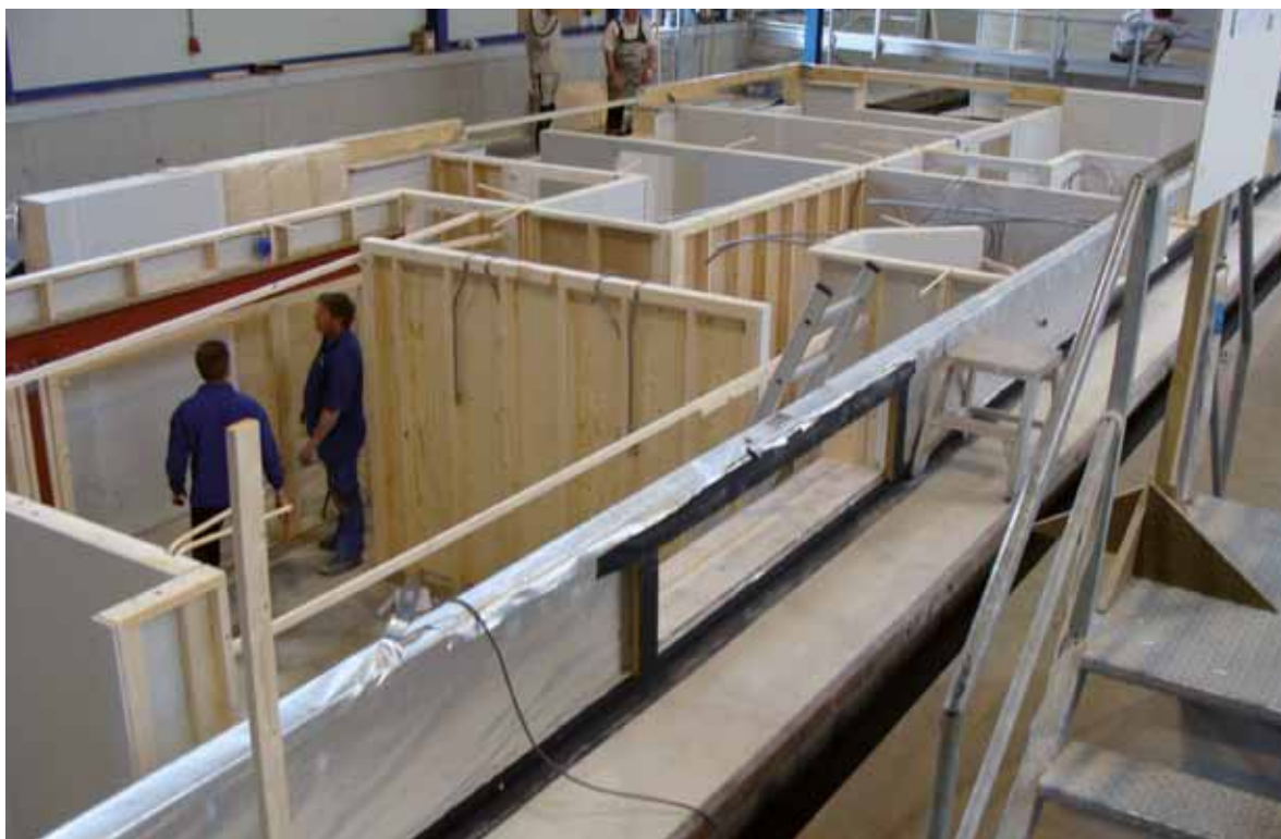
Foto boven: verblijfsruimte met 2,60 m stahoogte in onderbouw van een drijvende woning, met smalle raampjes boven de waterspiegel. Foto: ABC Arkenbouw.
