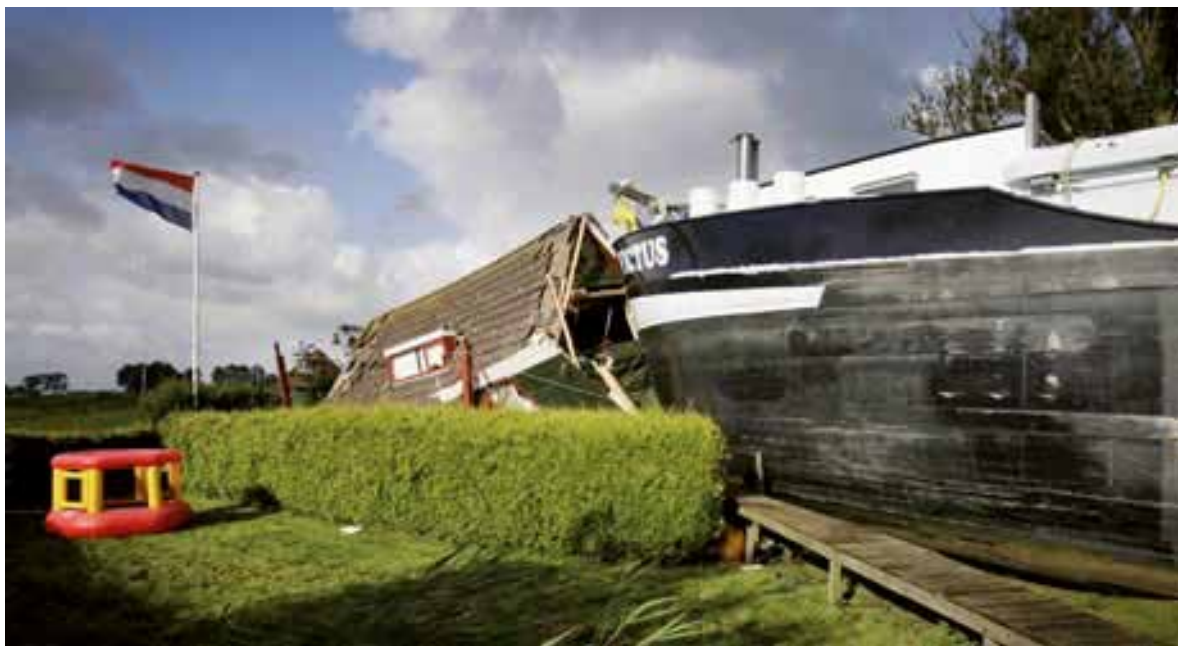
Foto boven: Het Bouwbesluit stelt geen eisen aan het berekenen van een constructie op botsing door vaartuigen. Binnenvaartschip ramt een vakantiewoning langs het Prinses Margrietkanaal in Friesland, juli 2007. Foto ANP, bron: http://www.ad.nl/binnenland/article1543785.ece
