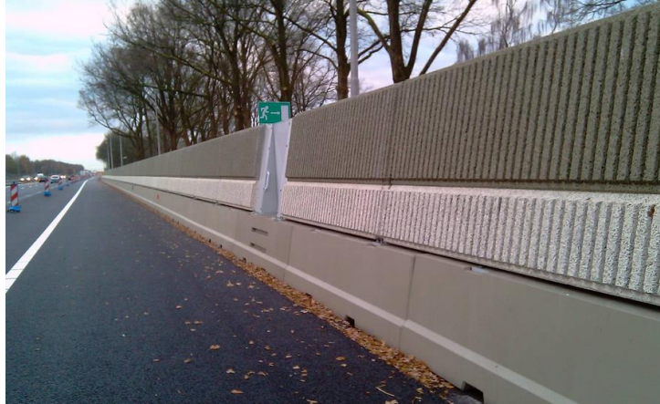
Figuur 6 Reanco barrier betreft het onderste deel van dit geluidscherm (foto: Reanco Benelux BV).
