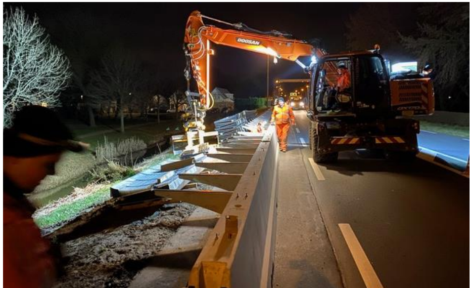
Figuur 17 Het monteren van de Whisbarrier in Vreeland (foto: 4Silence).
